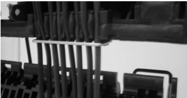
7.6 Coloque el seguro retenedor de las fibras de acometida. Si estos conductores no fueron colocados desde un principio por debajo del seguro de la terminal, desenganche el último candado del seguro pase las fibras por debajo.
