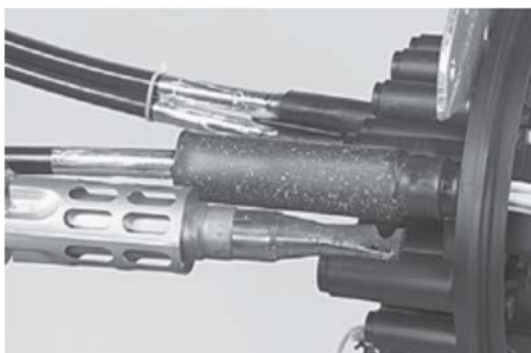
4.3.7 Comece a aquecer o selo da base; aguarde um minuto e encolha em movimentos em espiral descendentes.
