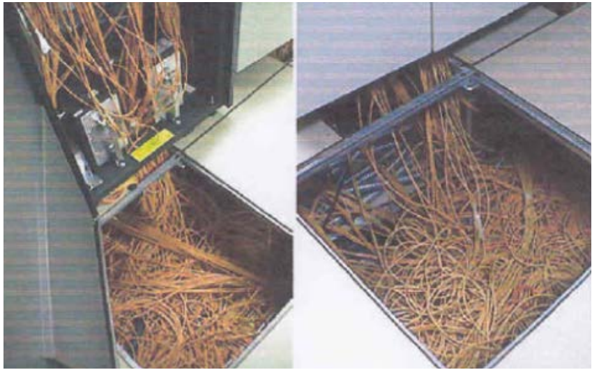
图 6: 点对点布线的非结构化增长示例 (来源: EN 50600-2-4)
