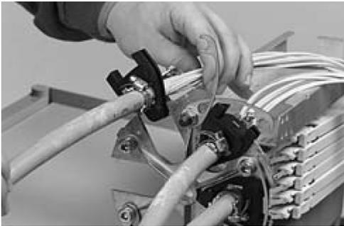
Instale los cables en la base metálica, los cables de la red principal deberán ser colocados en las posiciones 5 y 6 de la base
