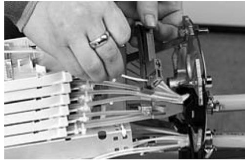
Cuando todas las fibras de un tubo holgado se usarán en el cierre, corte el tubo holgado y elimínelo hasta 55 mm del borde del cable.
