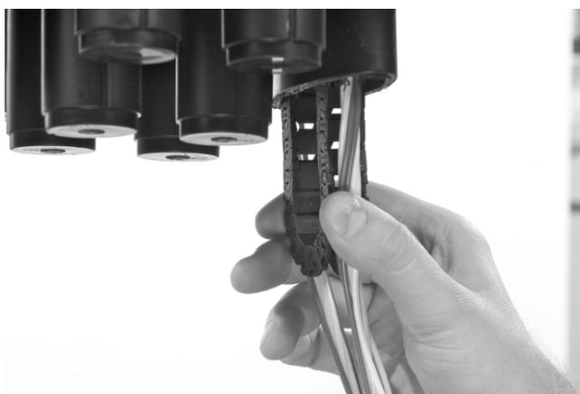
4.1.11 Insérer les tubes dans l'entrée/sortie ovale à l'aide du LCIT et les récupérer de l'autre côté. Enlever le LCIT et faire passer la totalité des tubes jusqu'à la pièce de terminaison de câble.
