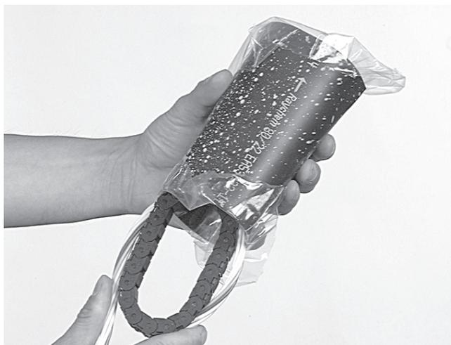
4.1.10 Éliminer toute trace de graisse et de saleté sur la gaine du câble sur environ 2 mètres, avec un chiffon propre. Positionner le LCIT (chaîne flexible) sur les tubes et l'insérer dans le manchon thermorétractable dont on aura pris soin de protéger l'adhésif avec son propre papier d'emballage que l'on aura ouvert à chaque extrémité. S'assurer que le manchon thermorétractable soit positionné dans le bon sens (la flèche vers l'embase du GCO2).
