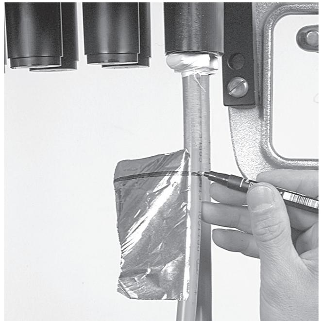
5.1.4 Enrouler la bande d'aluminium adhésive autour de chaque câble. Faire correspondre la ligne bleue de la bande aluminium avec la marque précédemment réalisée sur le câble.
