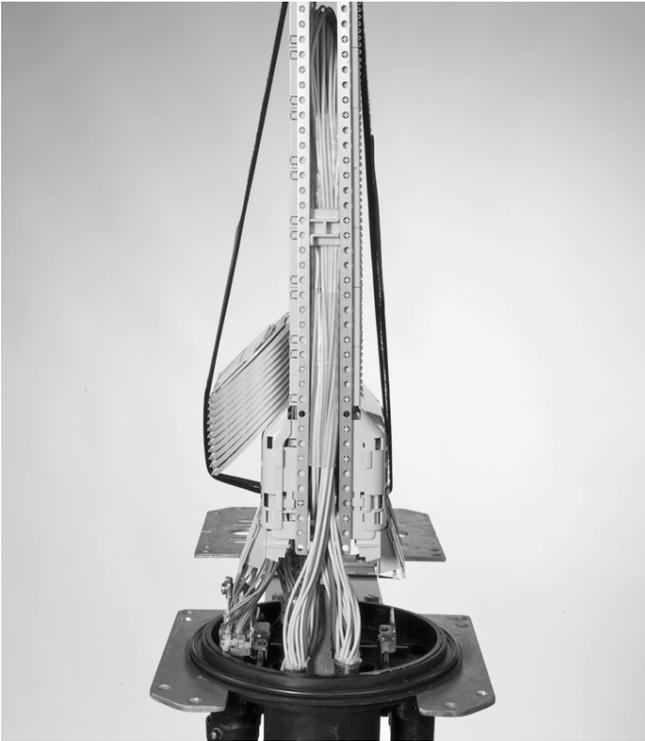
4.1.13 Réaliser des boucles avec les tubes en utilisant la technique du 8 inversé, placer ces boucles dans la poche plastique afin de les maintenir. Glisser le tout entre les UMS. Si la capacité des tubes en passages est trop importante pour passer entre les deux UMS, placer les boucles sur un des côtés de la platine et utiliser des colliers pour fixer les tubes.
