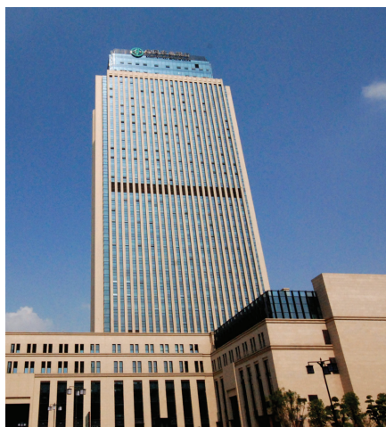
中国农业银行四川省分行数据中心大楼
